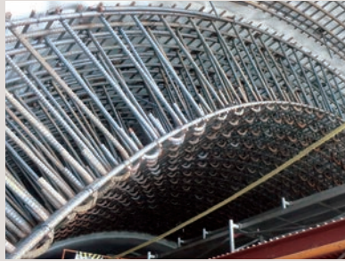
トンネル（アーチ部）
