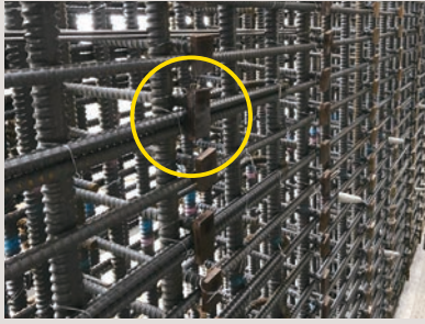
中空橋脚（重ね継手部）
