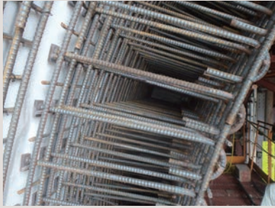
トンネル（アーチ部）
