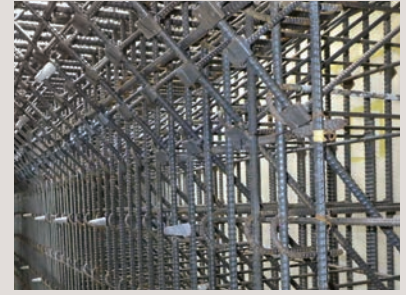
ボックスカルバート（隅角部）
